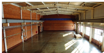
Цеха перед установкой оборудования
