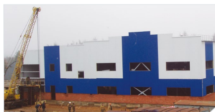
Возведение основного здания
