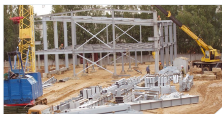
Начало строительства. 2006 год
